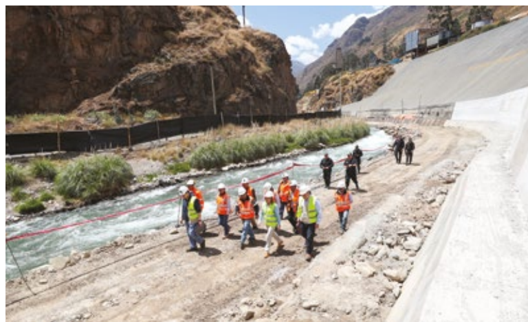
Desde la práctica de la Fiscalía, la determinación de la contravención de la normatividad administrativa, se construye en base a los informes técnicos que emiten los órganos reguladores.
